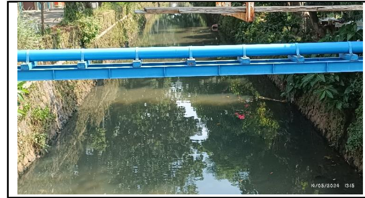
KONDISI PIPA UTILITAS AIR MINUM DAN ALIRAN SUNGAI
