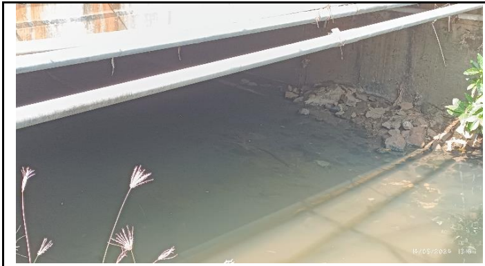
KONDISI BANGUNAN BAWAH
