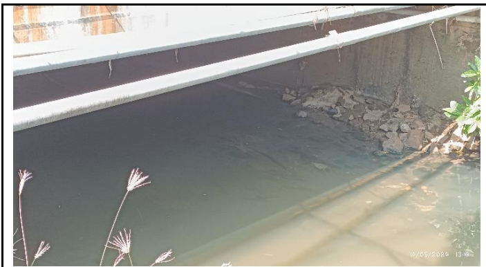
KONDISI BANGUNAN BAWAH
