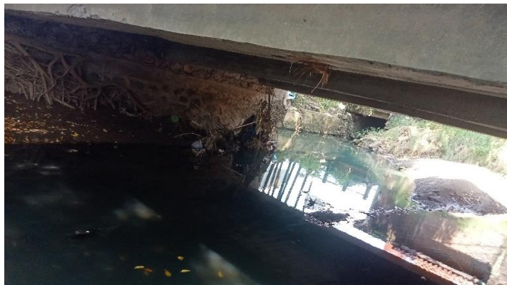
KONDISI BANGUNAN BAWAH
