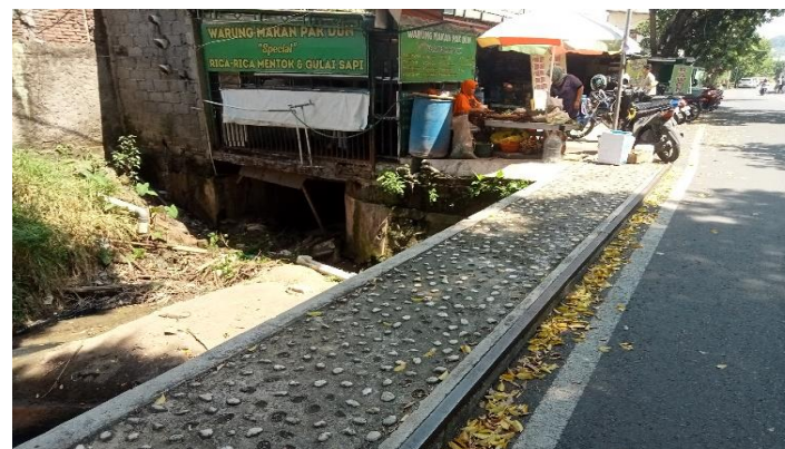
TIDAK ADA SANDARAN
