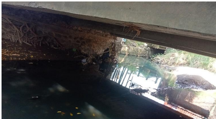
KONDISI BANGUNAN BAWAH
