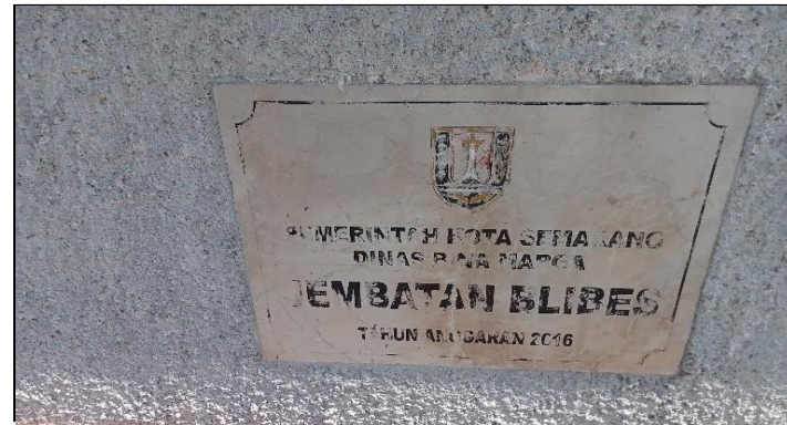
PAPAN NAMA JEMBATAN / PRASASTI
