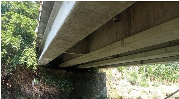
KONDISI BANGUNAN BAWAH
