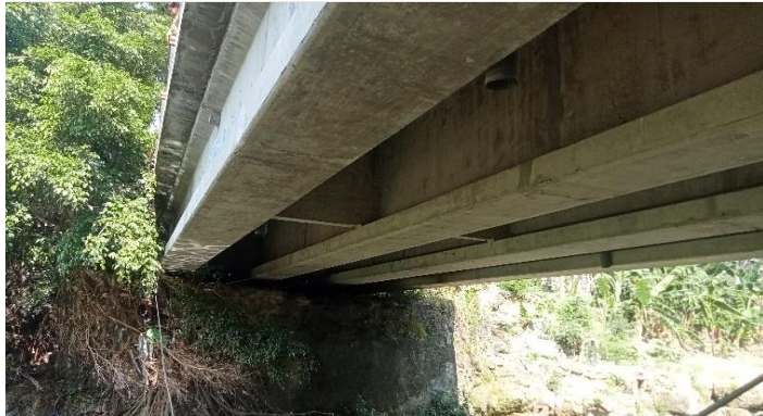
KONDISI BANGUNAN BAWAH
