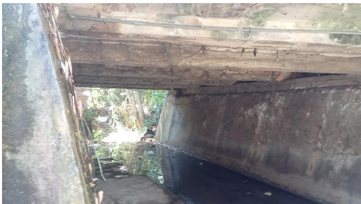
KONDISI BANGUNAN BAWAH
