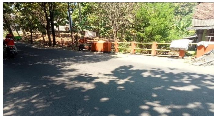
KONDISI LAPISAN PERMUKAAN LANTAI
