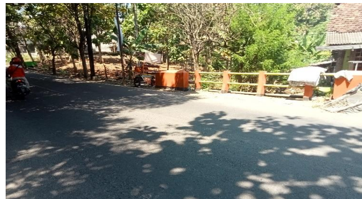
KONDISI LAPISAN PERMUKAAN LANTAI
