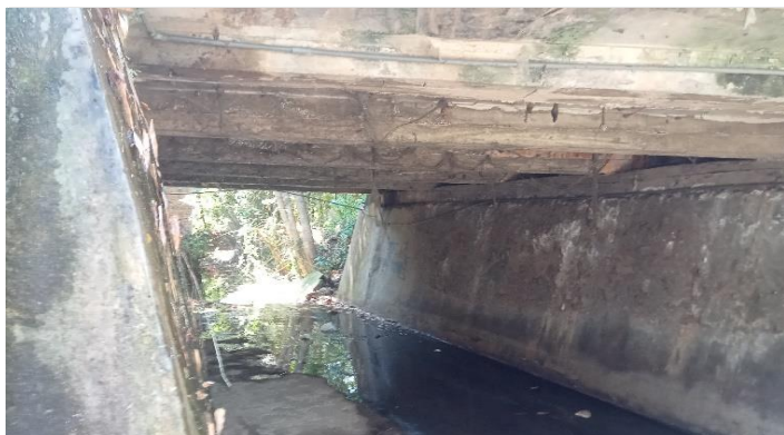
KONDISI BANGUNAN BAWAH
