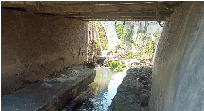
KONDISI BANGUNAN BAWAH
