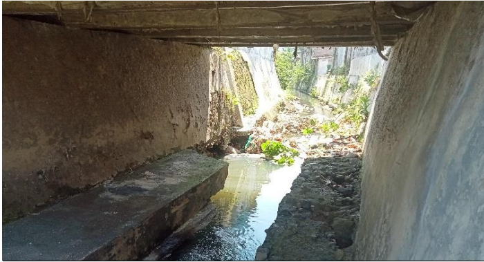
KONDISI BANGUNAN BAWAH
