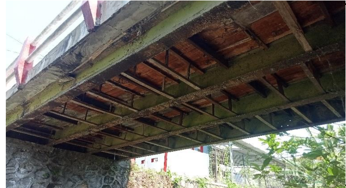
KONDISI BANGUNAN BAWAH
