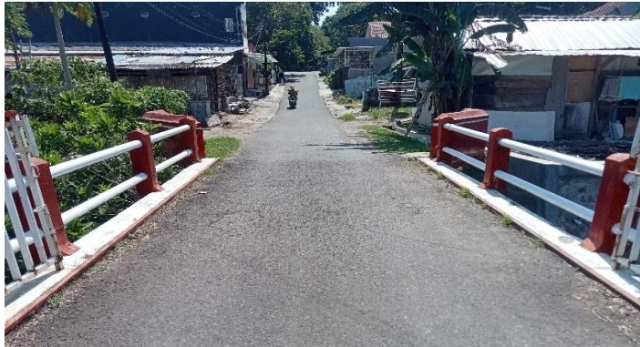
KONDISI LAPISAN PERMUKAAN LANTAI
