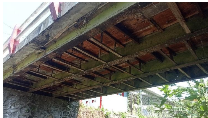
KONDISI BANGUNAN BAWAH
