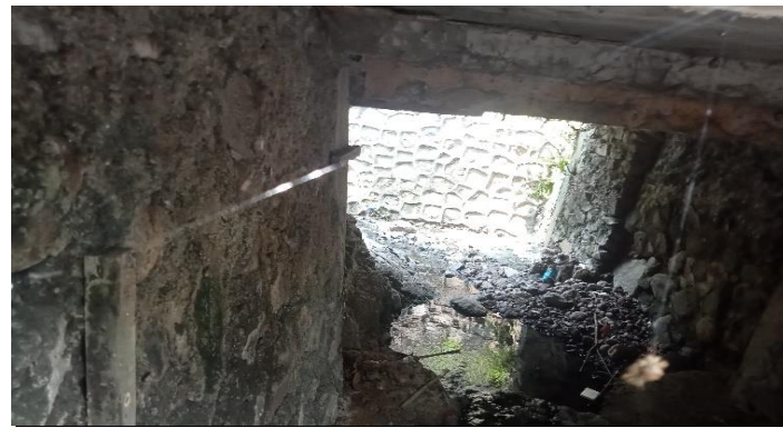
KONDISI BANGUNAN BAWAH
