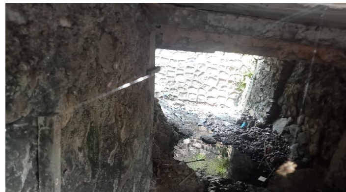
KONDISI BANGUNAN BAWAH
