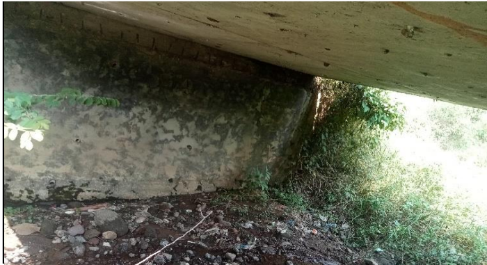
KONDISI BANGUNAN BAWAH
