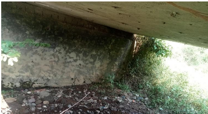
KONDISI BANGUNAN BAWAH
