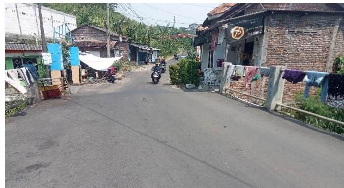
KONDISI LAPISAN PERMUKAAN LANTAI
