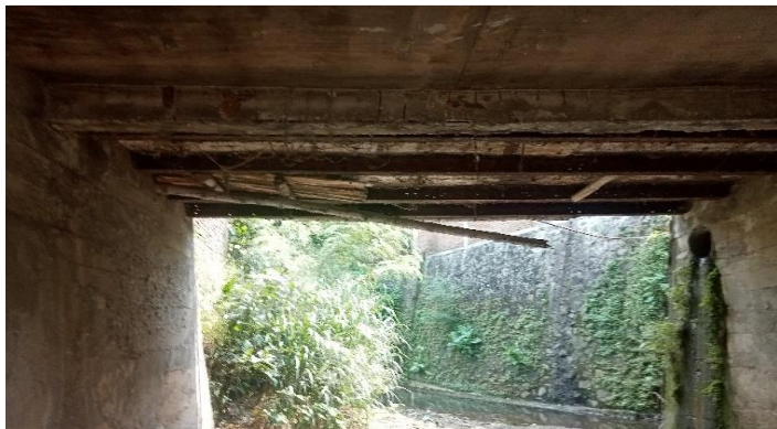
KONDISI BANGUNAN BAWAH
