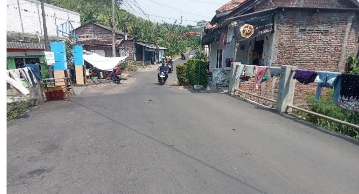
KONDISI LAPISAN PERMUKAAN LANTAI
