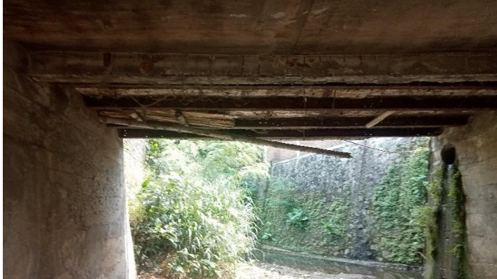
KONDISI BANGUNAN BAWAH
