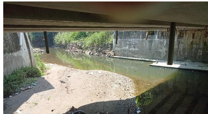
KONDISI BANGUNAN BAWAH
