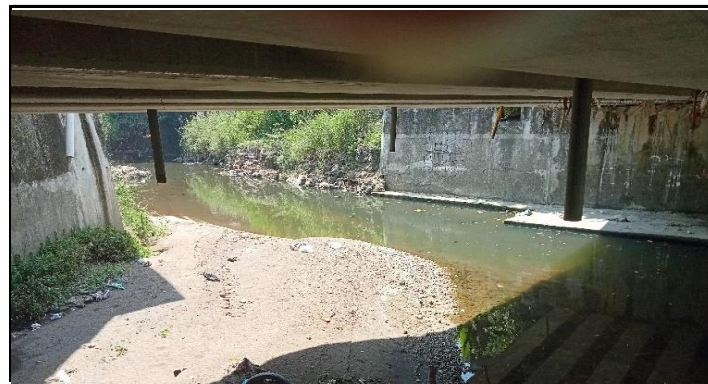
KONDISI BANGUNAN BAWAH
