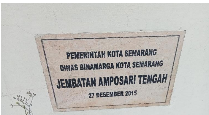
PAPAN NAMA JEMBATAN / PRASASTI
