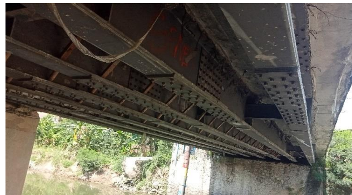
KONDISI BANGUNAN BAWAH
