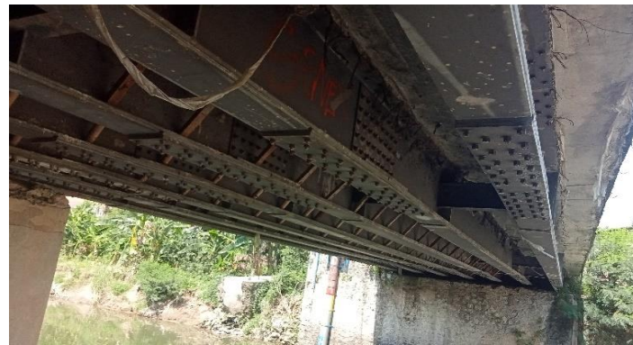
KONDISI BANGUNAN BAWAH
