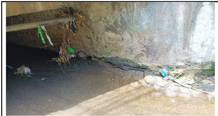
KONDISI KEPALA JEMBATAN DAN PONDASI
