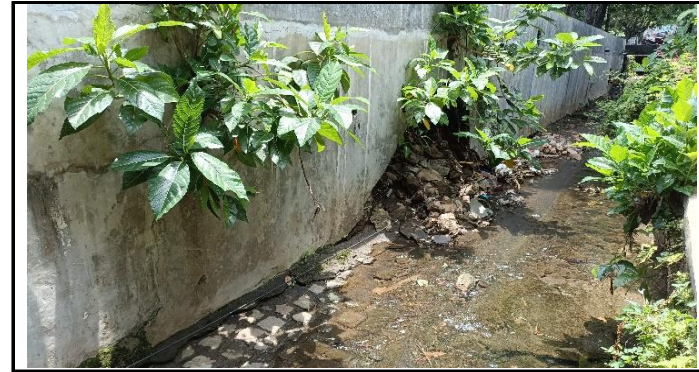
KONDISI TEBING SUNGAI
