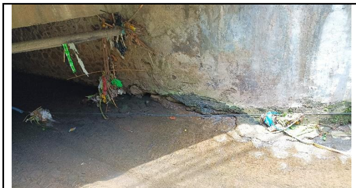
KONDISI KEPALA JEMBATAN DAN PONDASI
