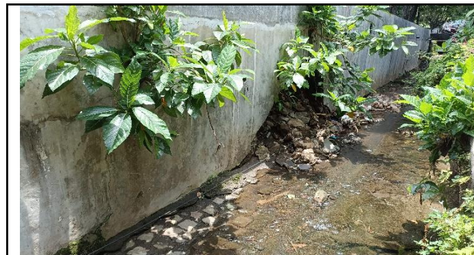
KONDISI TEBING SUNGAI
