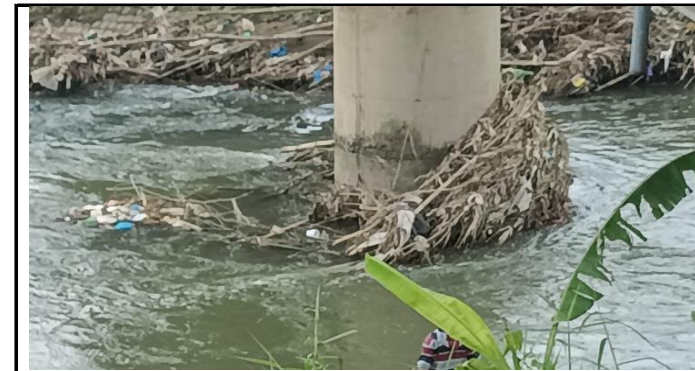
PENUMPUKAN DEBRIS (SAMPAH) PADA ALIRAN SUNGAI
