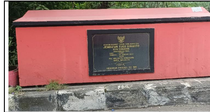
PAPAN NAMA JEMBATAN MASIH TERLIHAT JELAS
