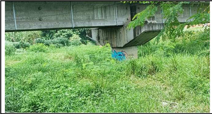
KONDISI BANGUNAN BAWAH JEMBATAN
