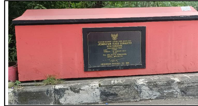
PAPAN NAMA JEMBATAN MASIH TERLIHAT JELAS
