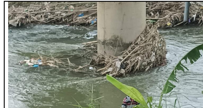
PENUMPUKAN DEBRIS (SAMPAH) PADA ALIRAN SUNGAI
