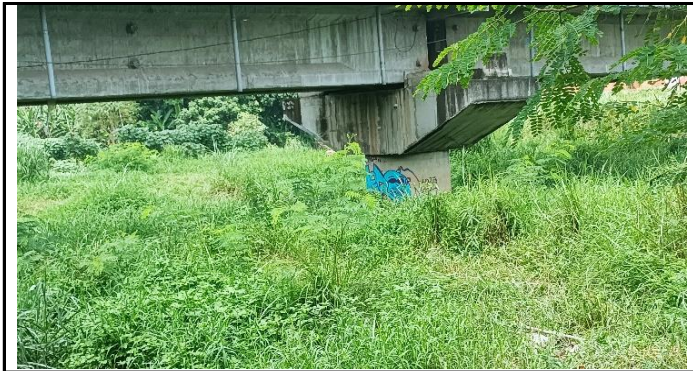
KONDISI BANGUNAN BAWAH JEMBATAN
