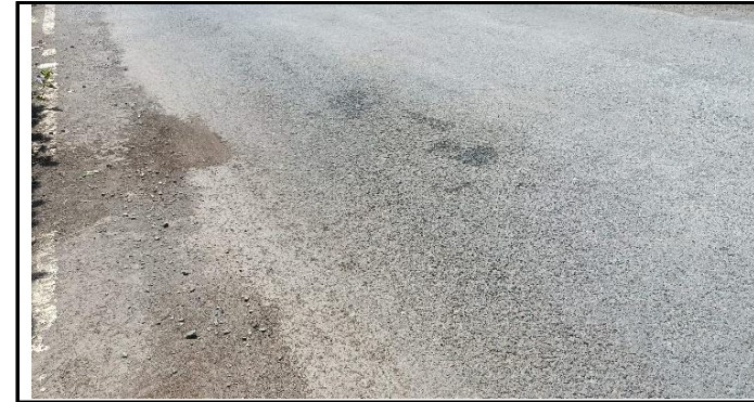
LAPISAN PERMUKAAN LANTAI LICIN PERLU PEMBERSIHAN PASIR
