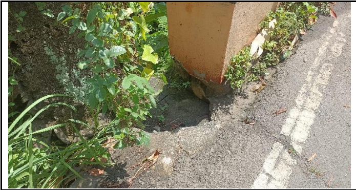
STRUKTUR LANTAI RETAK
