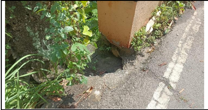
STRUKTUR LANTAI RETAK
