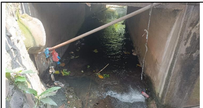
KONDISI BANGUNAN BAWAH
