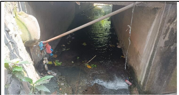
KONDISI BANGUNAN BAWAH
