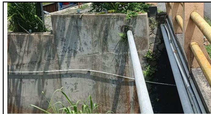
KONDISI TEBING SUNGAI
