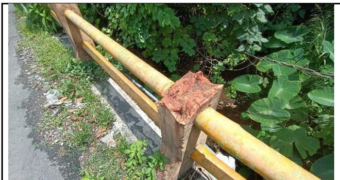
KONDISI SANDARAN JEMBATAN
