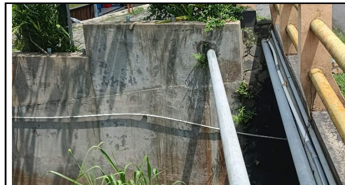
KONDISI TEBING SUNGAI
