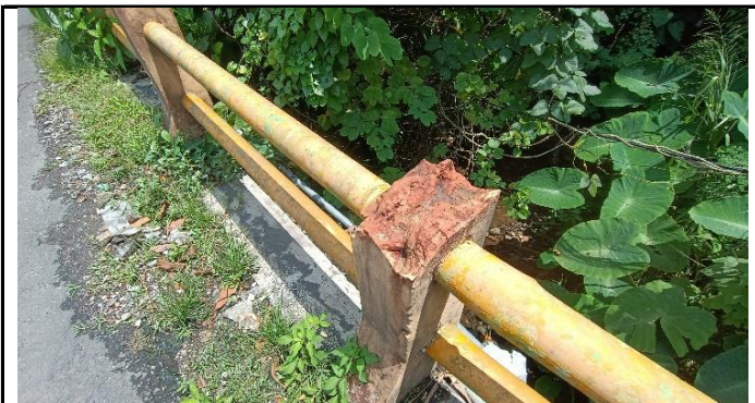
KONDISI SANDARAN JEMBATAN
