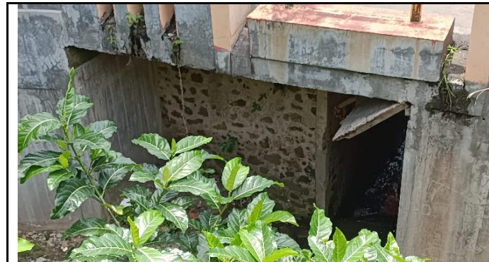
KONDISI KEPALA JEMBATAN
