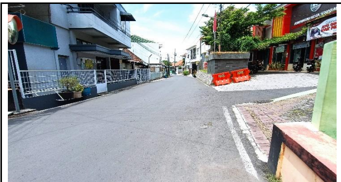
KONDISI LANTAI PERMUKAAN JALAN PENDEKAT
