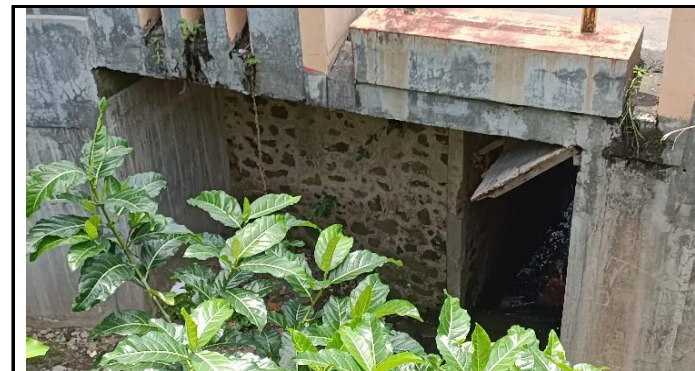
KONDISI KEPALA JEMBATAN
