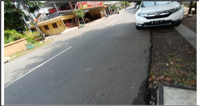
KONDISI JALAN PENDEKAT
