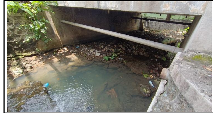
KONDISI BANGUNAN BAWAH
