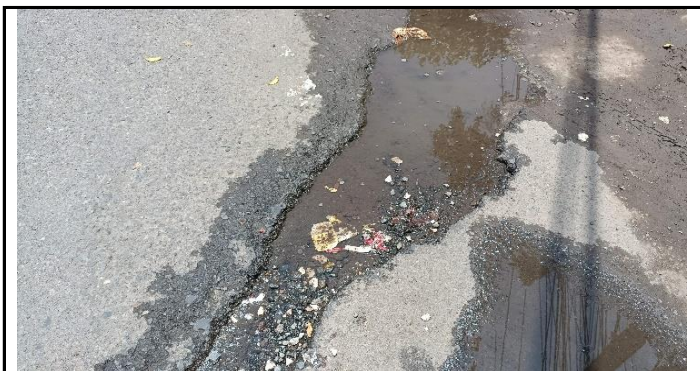
KONDISI LAPISAN PERMUKAAN LANTAI
