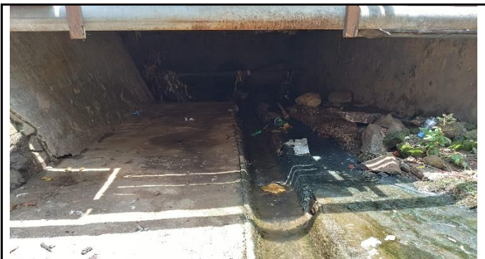
KONDISI BANGUNAN BAWAH
