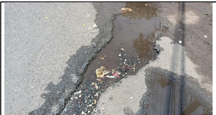
KONDISI LAPISAN PERMUKAAN LANTAI
