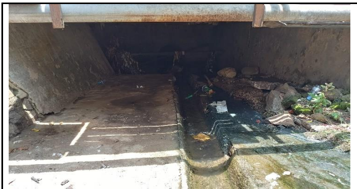
KONDISI BANGUNAN BAWAH
