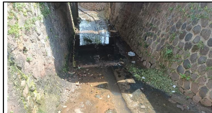
KONDISI PENGAMAN ALIRAN SUNGAI
