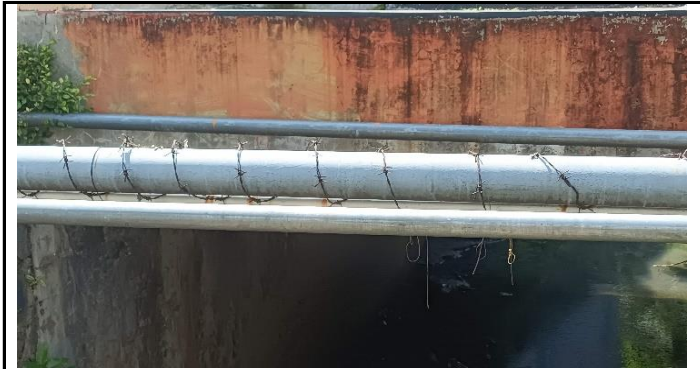
KONDISI PIPA UTILITAS
