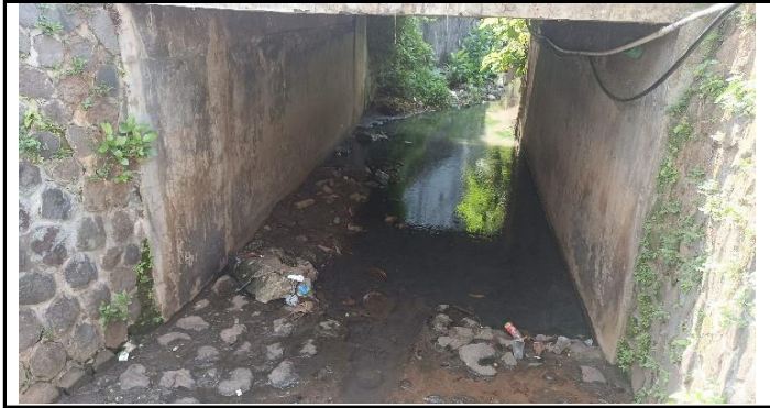
KONDISI KEPALA JEMBATAN
