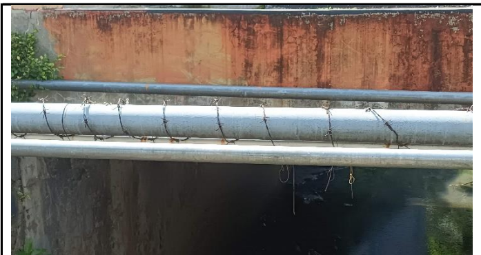
KONDISI PIPA UTILITAS
