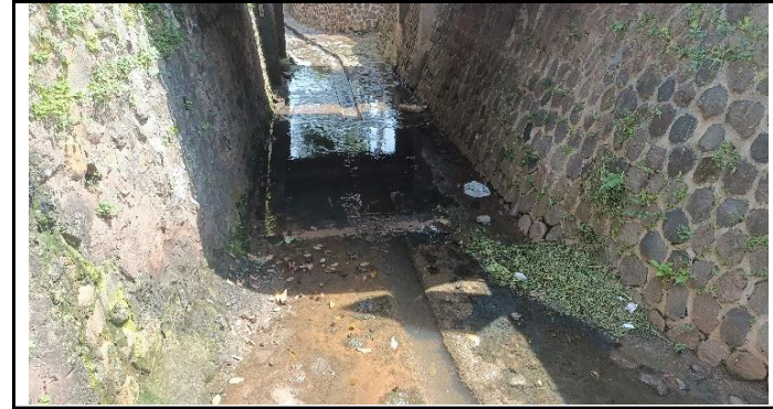
KONDISI PENGAMAN ALIRAN SUNGAI
