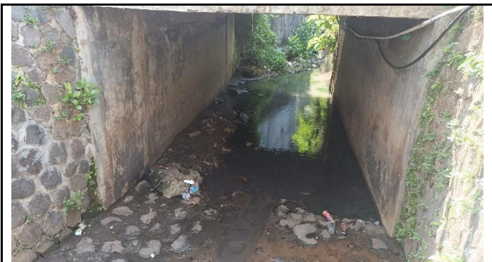
KONDISI KEPALA JEMBATAN
