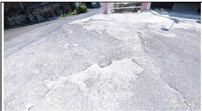
LAPISAN PERMUKAAN LANTAI BERLUBANG
