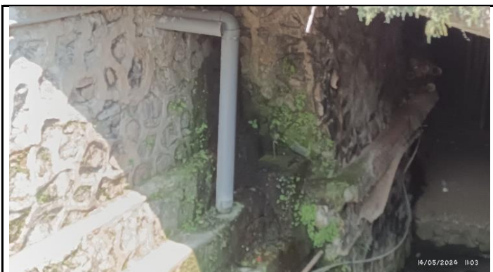
KONDISI KEPALA JEMBATAN
