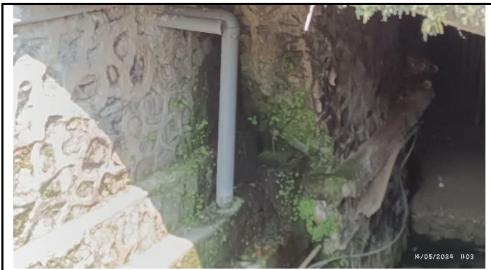
KONDISI KEPALA JEMBATAN
