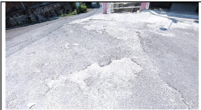
LAPISAN PERMUKAAN LANTAI BERLUBANG
