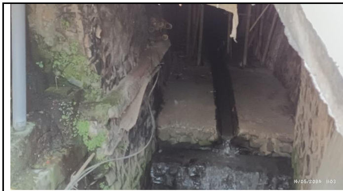
KONDISI BANGUNAN BAWAH
