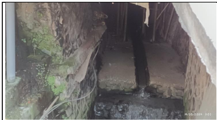
KONDISI BANGUNAN BAWAH
