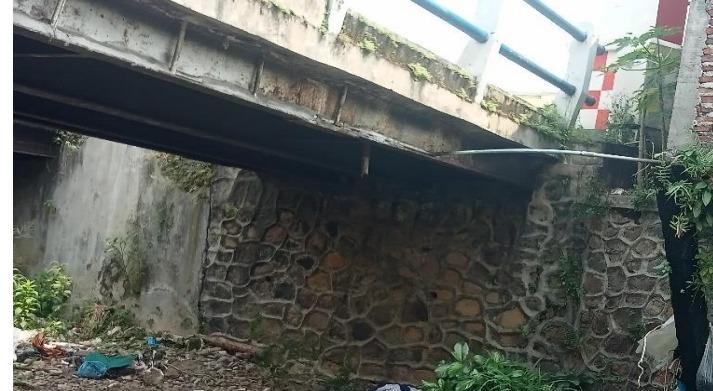
KONDISI BANGUNAN BAWAH
