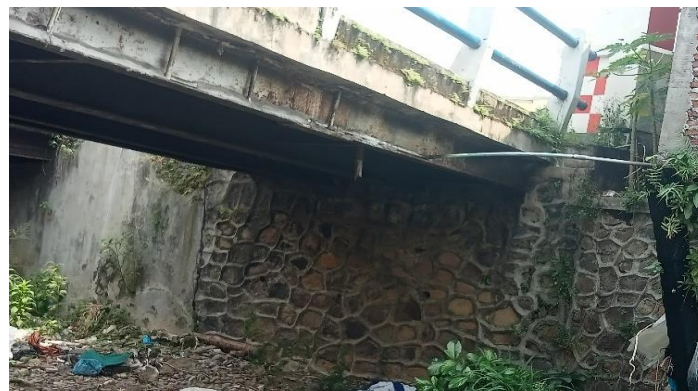
KONDISI BANGUNAN BAWAH
