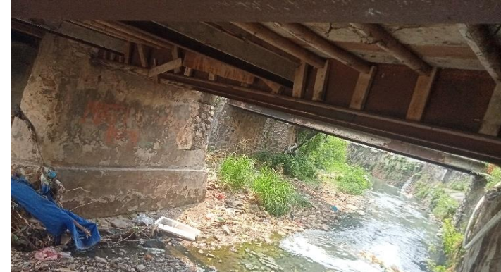
KONDISI BANGUNAN BAWAH
