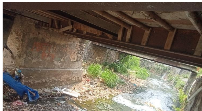
KONDISI BANGUNAN BAWAH
