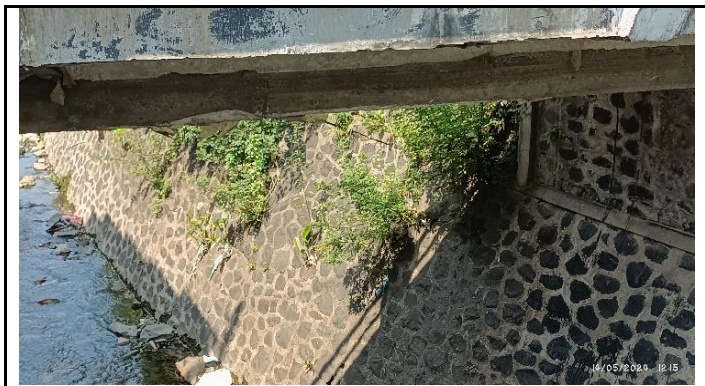
KONDISI GELAGAR BETON
