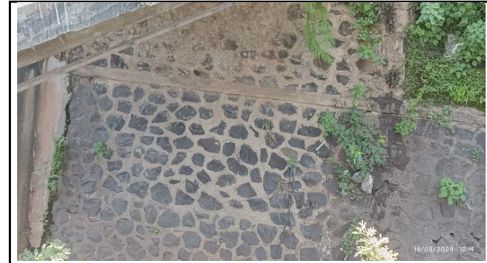
KONDISI KEPALA JEMBATAN
