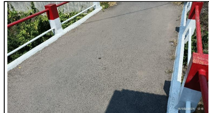
KONDISI LAPISAN PERMUKAAN LANTAI
