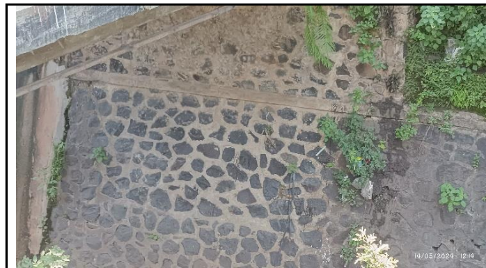
KONDISI KEPALA JEMBATAN
