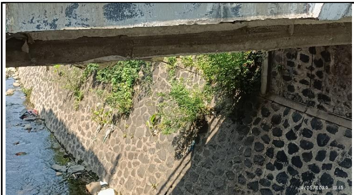
KONDISI GELAGAR BETON
