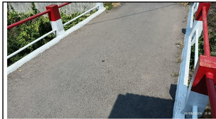
KONDISI LAPISAN PERMUKAAN LANTAI
