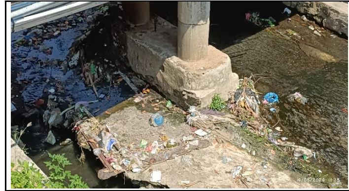
KONDISI PILAR JEMBATAN
