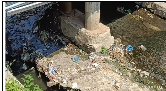
KONDISI PILAR JEMBATAN
