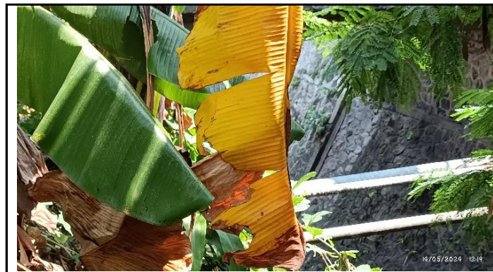
KONDISI KEPALA JEMBATAN
