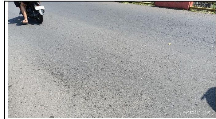
KONDISI LAPISAN PERMUKAAN LANTAI
