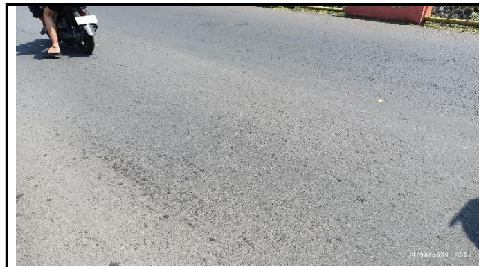
KONDISI LAPISAN PERMUKAAN LANTAI
