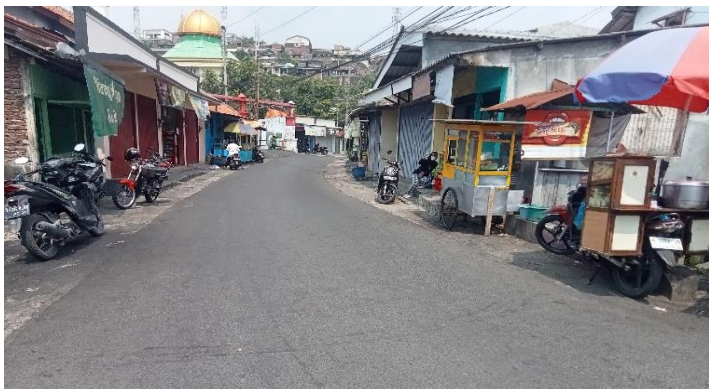
KONDISI LAPISAN PERMUKAN LANTAI
