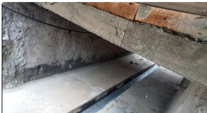
KONDISI BANGUNAN BAWAH
