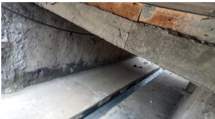
KONDISI BANGUNAN BAWAH
