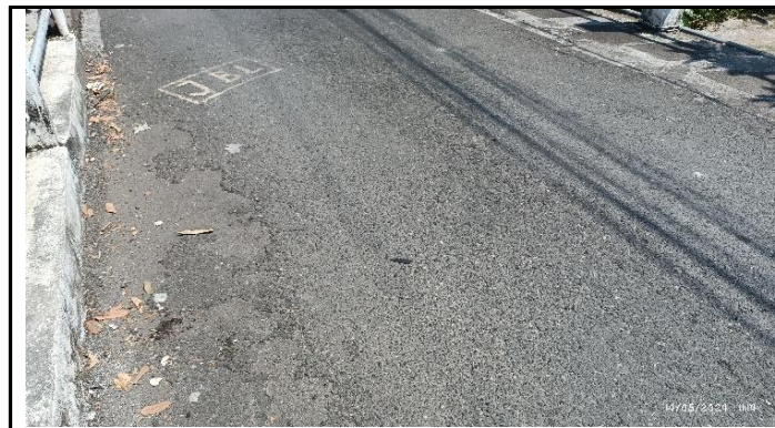
KONDISI LAPISAN PERMUKAAN LANTAI
