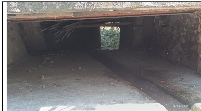
KONDISI BANGUNAN BAWAH
