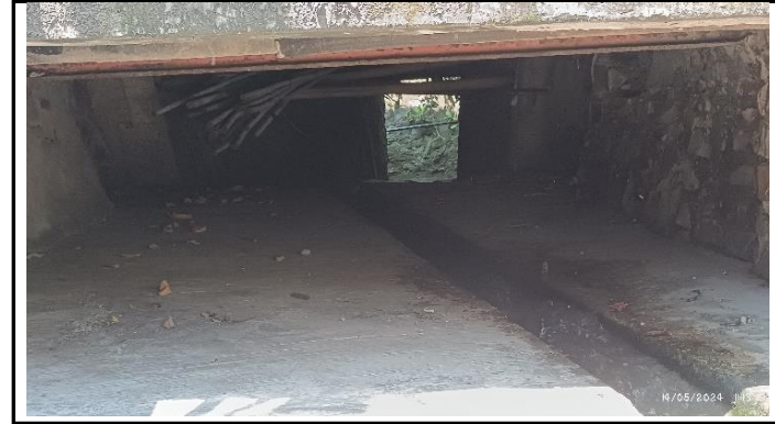
KONDISI BANGUNAN BAWAH
