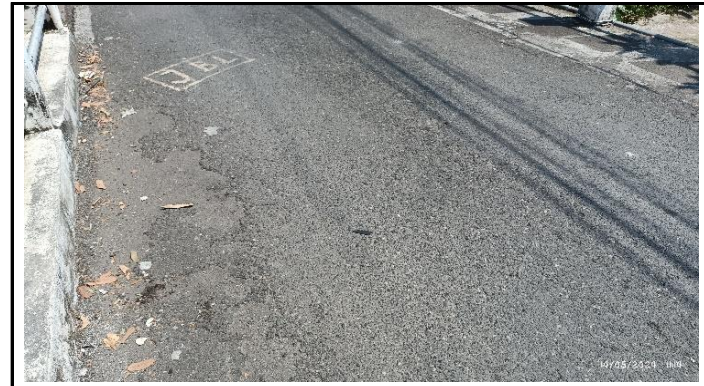
KONDISI LAPISAN PERMUKAAN LANTAI
