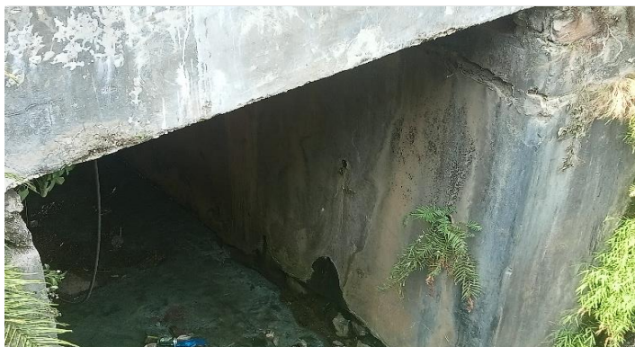
KONDISI BANGUNAN BAWAH
