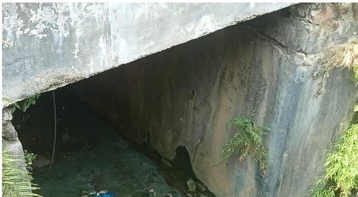
KONDISI BANGUNAN BAWAH
