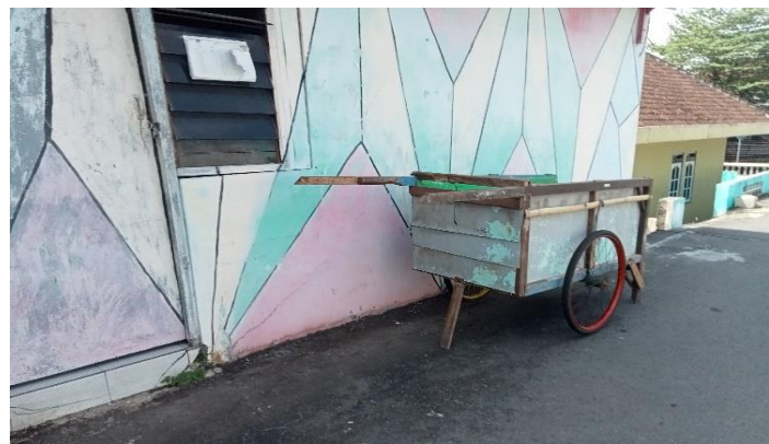
TERDAPAT BANGUNAN DI ATAS JEMBATAN
