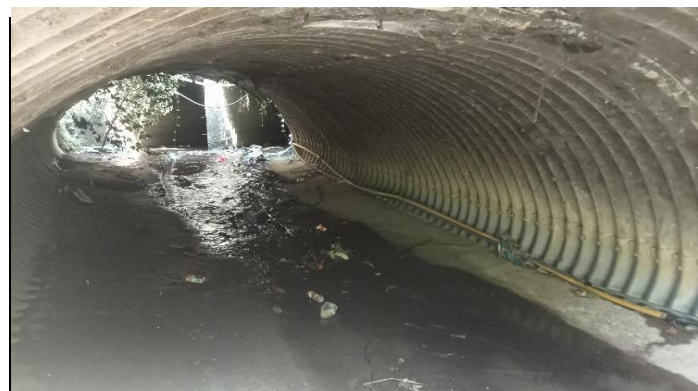
KONDISI BANGUNAN BAWAH
