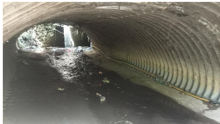
KONDISI BANGUNAN BAWAH
