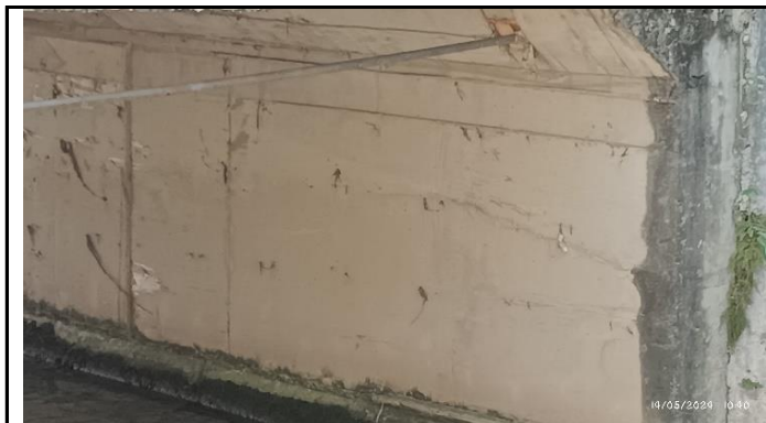
KONDISI KEPALA JEMBATAN
