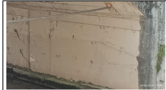
KONDISI KEPALA JEMBATAN
