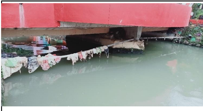
KONDISI BANGUNAN BAWAH
