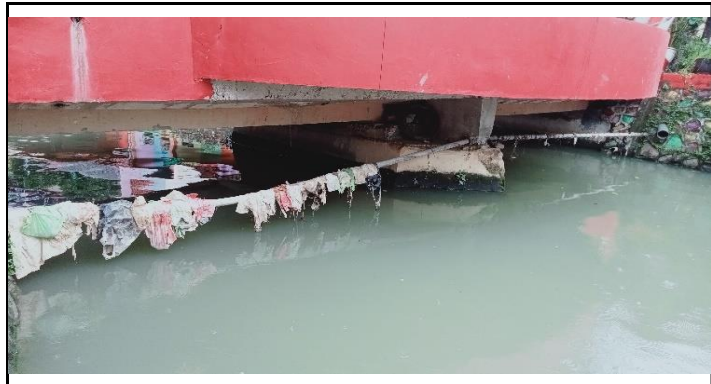
KONDISI BANGUNAN BAWAH
