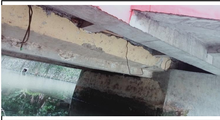
KONDISI BANGUNAN BAWAH
