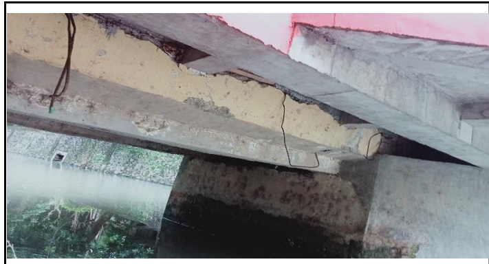
KONDISI BANGUNAN BAWAH
