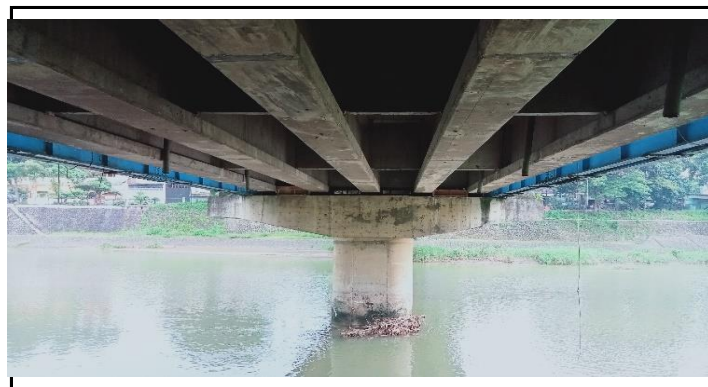
KONDISI BANGUNAN BAWAH
