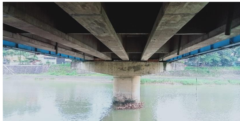
KONDISI BANGUNAN BAWAH
