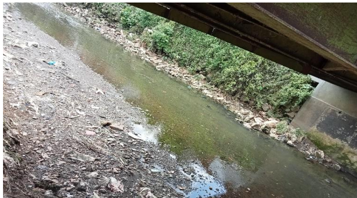
KONDISI BANGUNAN BAWAH
