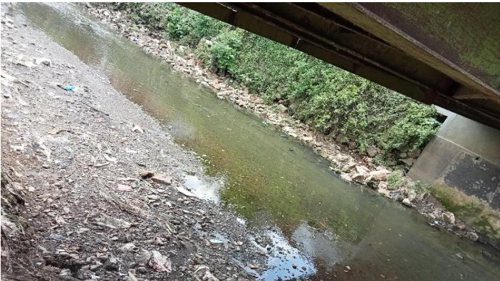
KONDISI BANGUNAN BAWAH
