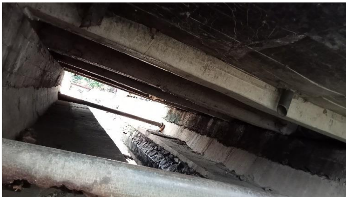
KONDISI BANGUNAN BAWAH
