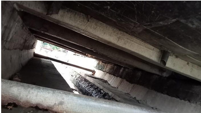
KONDISI BANGUNAN BAWAH
