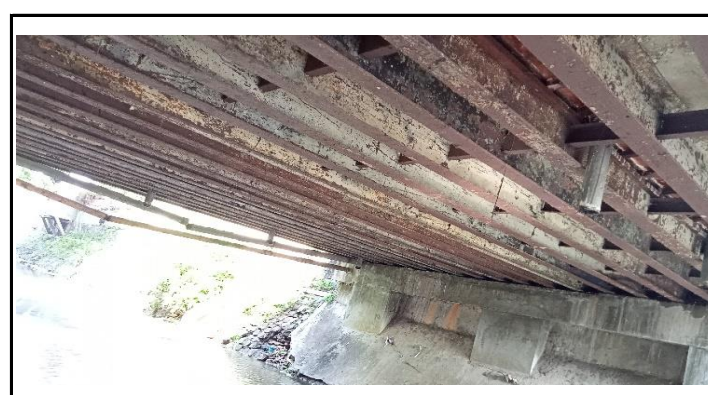
KONDISI BANGUNAN BAWAH
