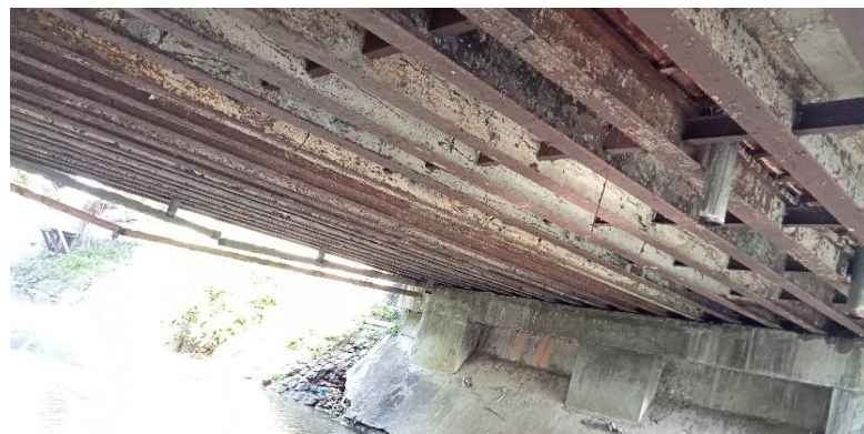
KONDISI BANGUNAN BAWAH
