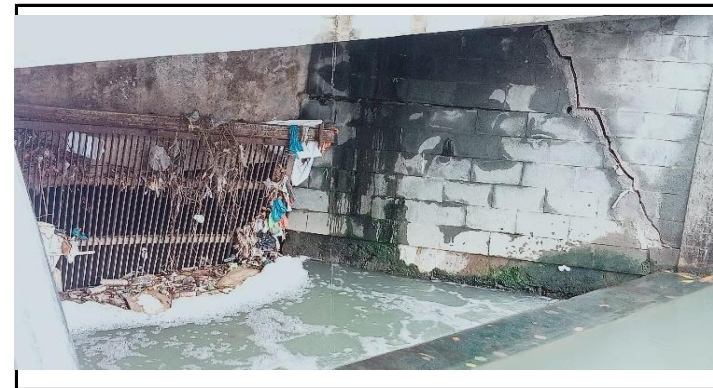
KONDISI BANGUNAN BAWAH
