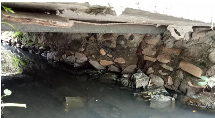
KONDISI BANGUNAN BAWAH
