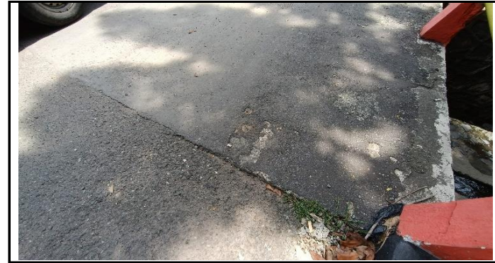
KONDISI LAPISAN PERMUKAAN LANTAI JEMBATAN
