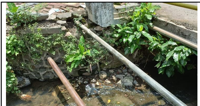
KONDISI PIPA UTILITAS
