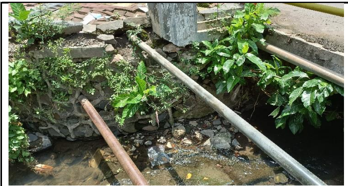
KONDISI PIPA UTILITAS
