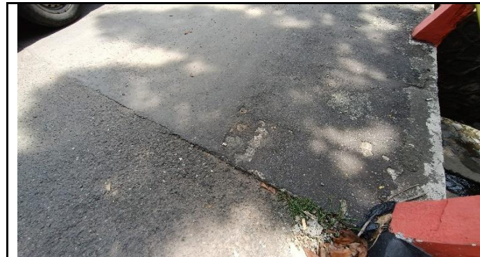
KONDISI LAPISAN PERMUKAAN LANTAI JEMBATAN
