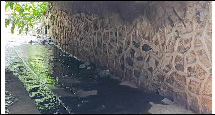
KONDISI KEPALA JEMBATAN
