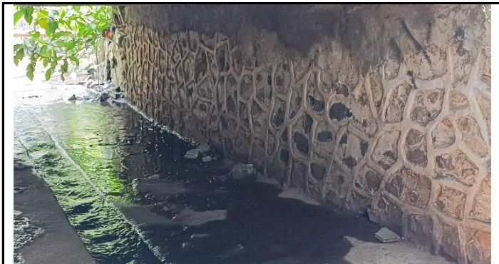
KONDISI KEPALA JEMBATAN
