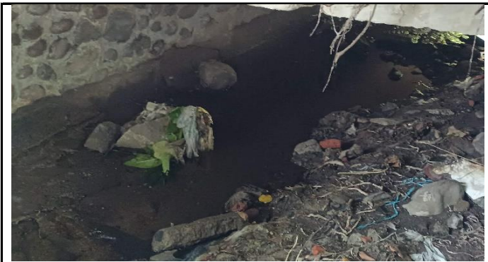
KONDISI BANGUNAN BAWAH
