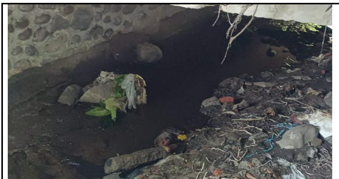
KONDISI BANGUNAN BAWAH
