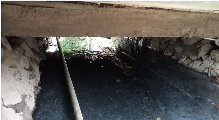
KONDISI BANGUNAN BAWAH
