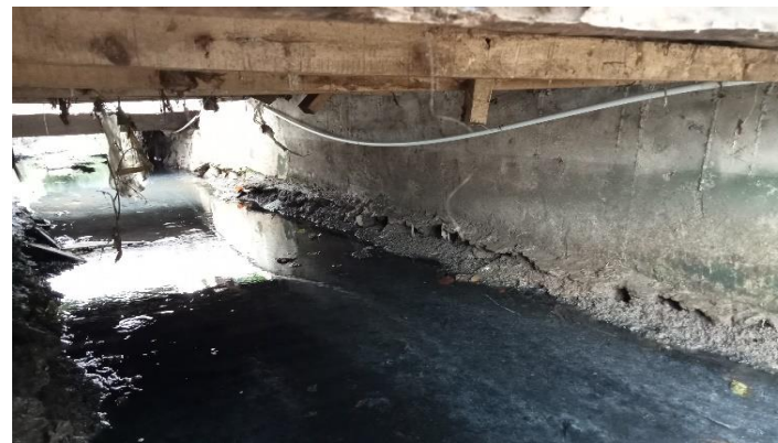
KONDISI BANGUNAN BAWAH
