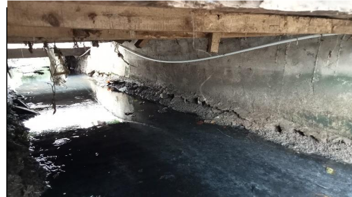
KONDISI BANGUNAN BAWAH
