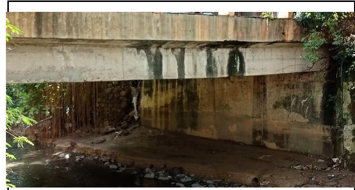
KONDISI BANGUNAN BAWAH
