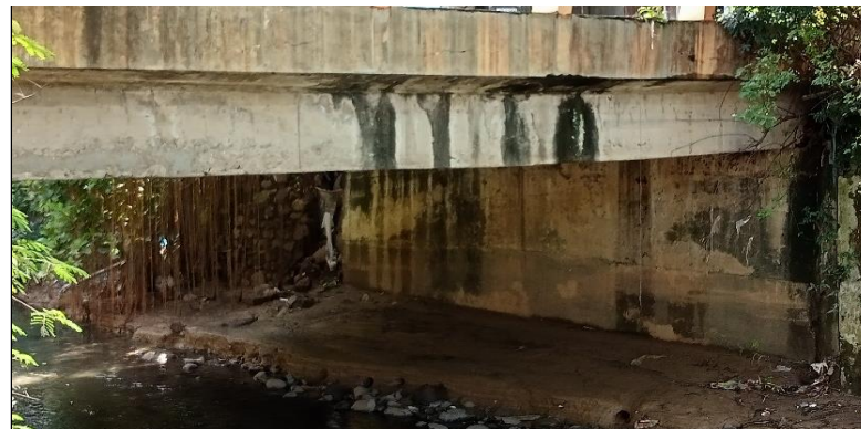
KONDISI BANGUNAN BAWAH
