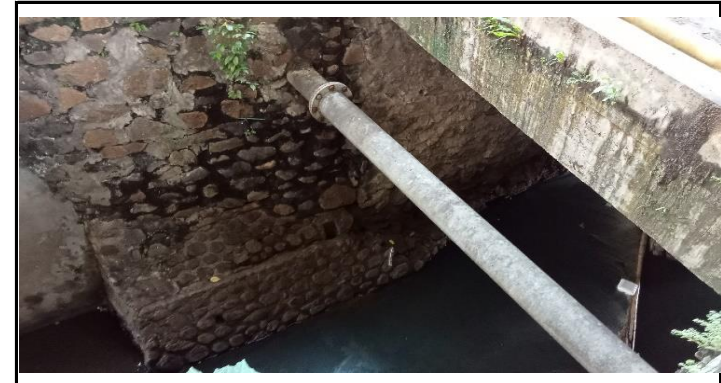
KONDISI BANGUNAN BAWAH
