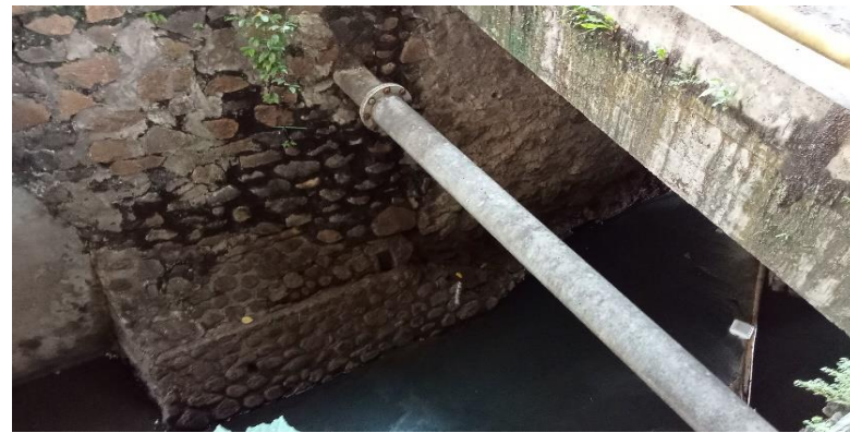
KONDISI BANGUNAN BAWAH
