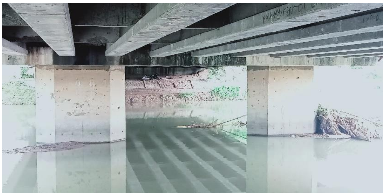
KONDISI BANGUNAN BAWAH
