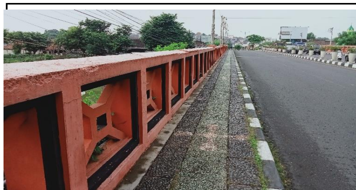
KONDISI SANDARAN DAN TROTOAR
