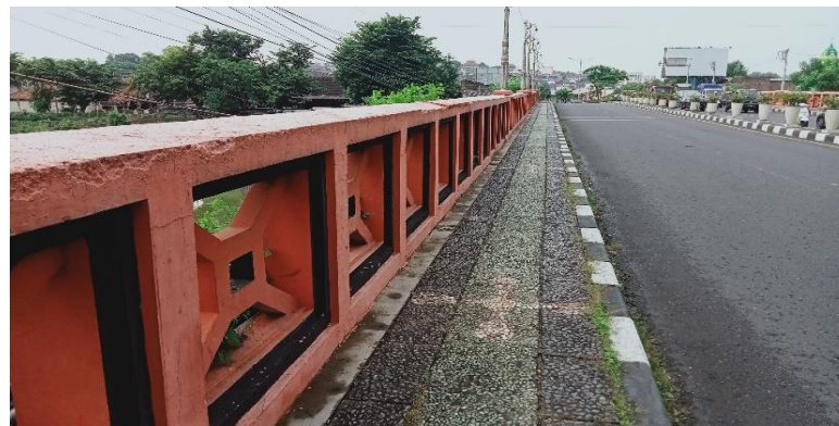
KONDISI SANDARAN DAN TROTOAR
