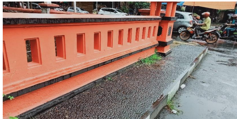
KONDISI SANDARAN DAN TROTOAR
