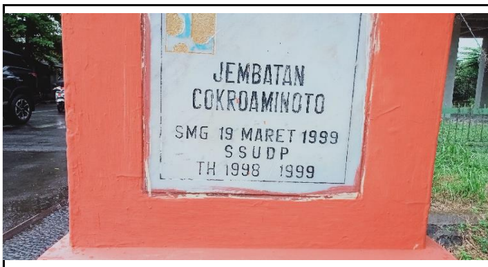
PAPAN NAMA JEMBATAN
