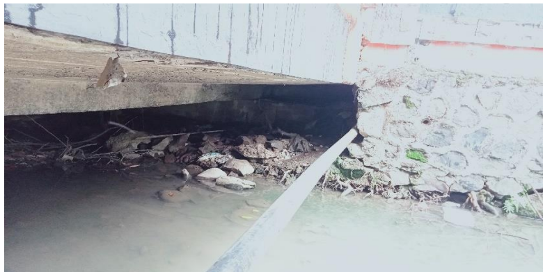
KONDISI BANGUNAN BAWAH
