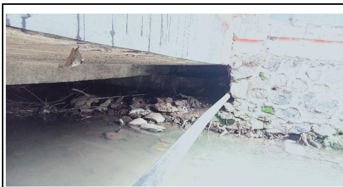
KONDISI BANGUNAN BAWAH
