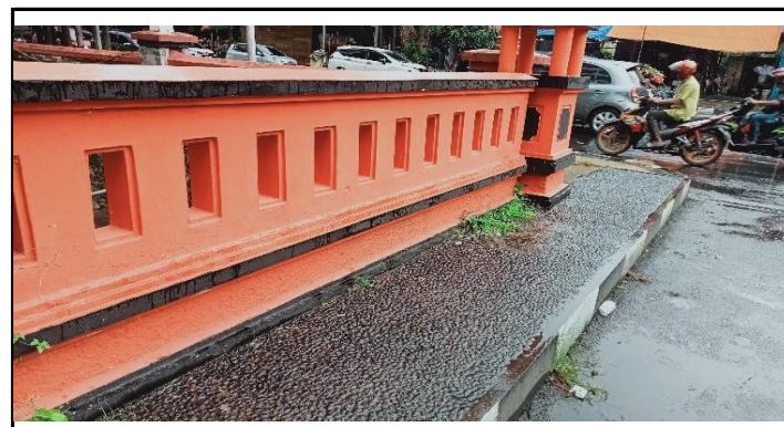
KONDISI SANDARAN DAN TROTOAR
