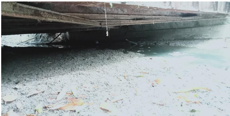
KONDISI BANGUNAN BAWAH
