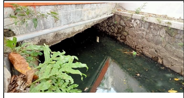
KONDISI BANGUNAN BAWAH
